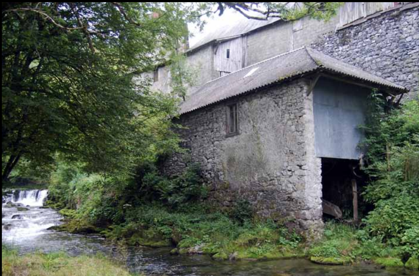
Lieu dit Henne Morte, moulin 1, réactivation de la production d'énergie hydroélectrique. Décentralisation du réseau, autonomisation et mutualisation de la production.
