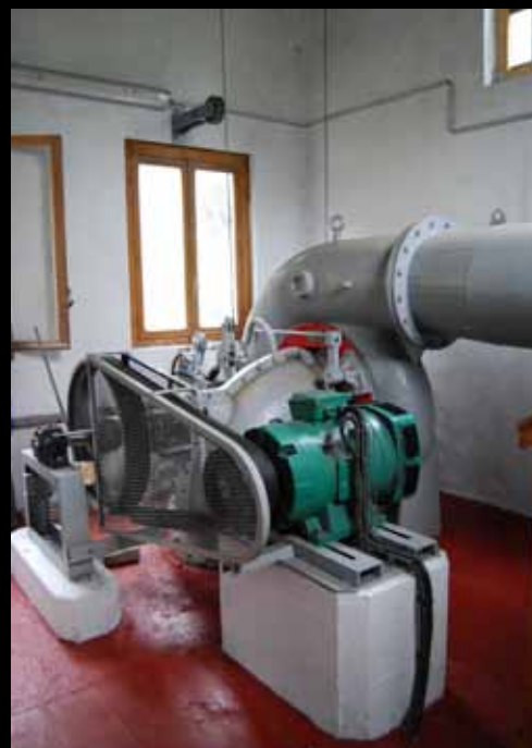
Turbine hydroélectrique installée dans un village voisin.
