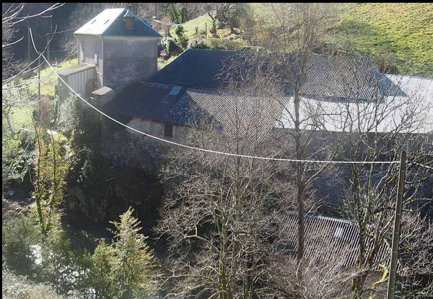
Lieu dit Henne Morte réhabilitation de l'ancienne auberge et actualisation de la plateforme, des activités et du lieu de vie.
