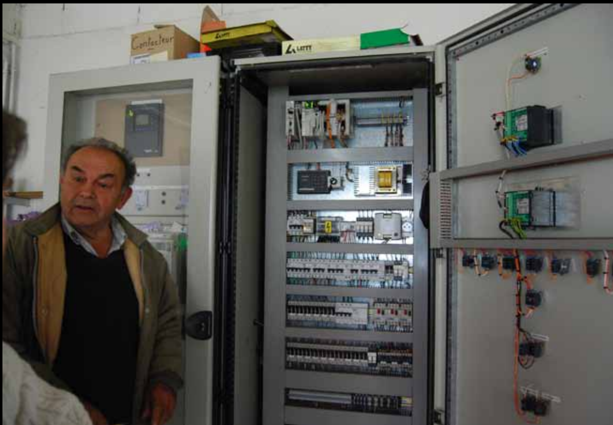
Mr Cazalé et son installation hydroélectrique
