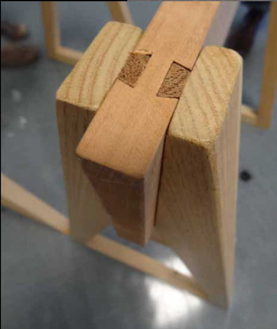
Trétraux démontable, assemblage en queue d'arronde, cerisier, frêne et châtaigner.
